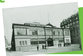
Ansicht der Frankfurter Markthalle, um 1880 (Foto: Hertel)
