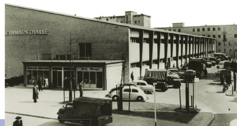
Anbau mit Eingang an der Ziegelgasse, 1954
